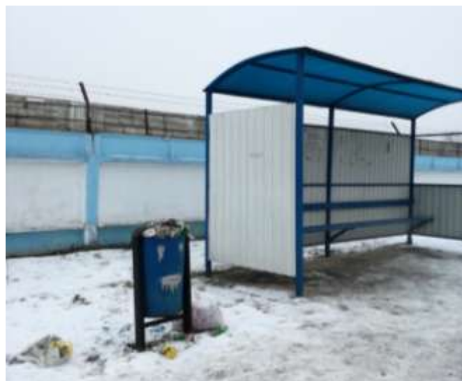
Остановка маршрутного транспорта «Автопарк» в г. Слониме (Слонимское ГУП ЖКХ)
