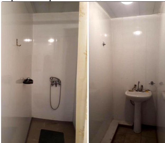
Душевая в РММ государственного предприятия «Дружба-Агро»: проведен ремонт
